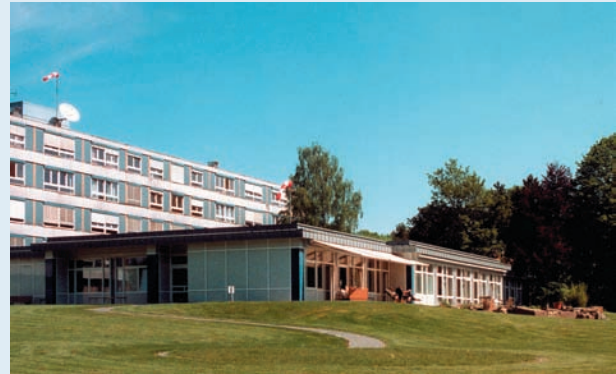
Dem Hauptgebäude vorgelagert: die Palliativstation mitten im Grünen.
